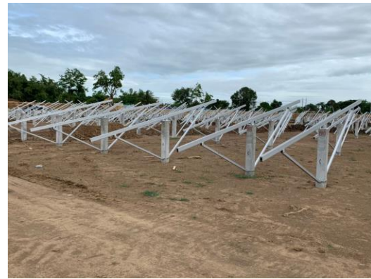
2) การติดตั้งงานโครงสร้างรับแผงเซลล์แสงอาทิตย์
