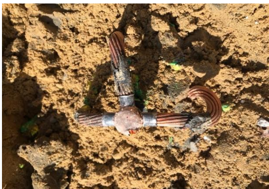
5) การติดตั้งระบบ Grounding
